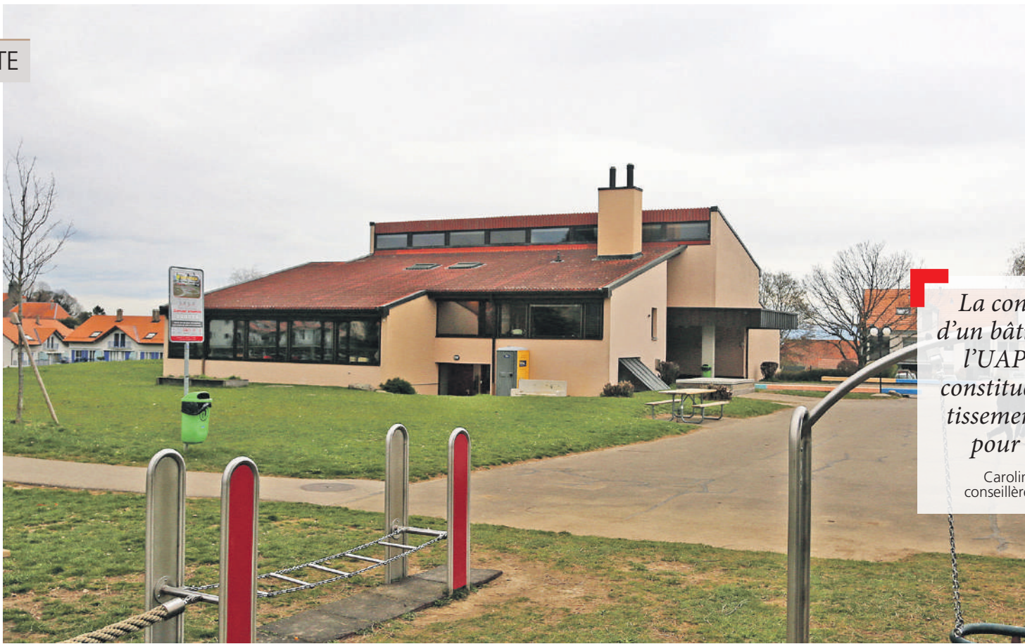
Le collège de Pampigny fera l'objet d'une importante extension. Des travaux auront aussi lieu dans le bâtiment originel. Jotterand
